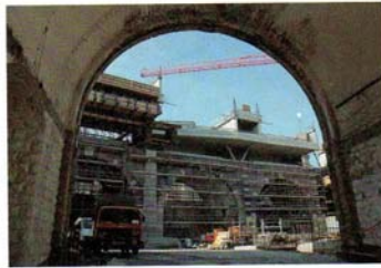
14 Uhr im Skyline im 19. Bezirk: Bürohausbau einmal ganz anders. Die alten Stadtbahnbögen sind das Fundament für die neuen Büros
