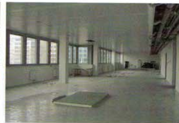
Das große Plus bei der E-Zone: große funktionale Flächen, durch die Fenster sieht man schemenhaft hinüber zur Telekom Austria
