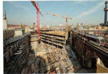
Blick von oben auf die Skyline-Baustelle: Die tolle Verkehrsanbindung (rechts U-Bahn) kann auch als Lärmbelastung empfunden werden
