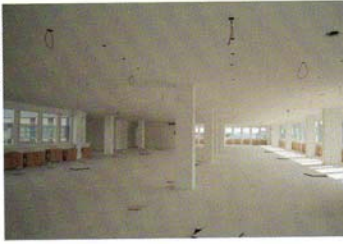
Noch leeres Büro im Big Biz: Die große Fläche hat unten bei der Lobby noch gestört, jetzt bringt sie dem Mieter viel Platz zum Arbeiten
