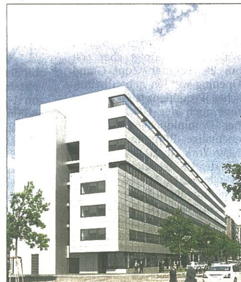
Das Projekt 2nd Central Office am Park mit rund 15.000 m² gehört zu den größten Fertigstellungen 2013. Vor Kurzem wurde es verkauft. [raiffeisen evolution]
